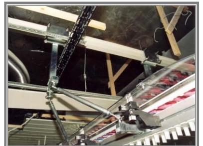
Bild 7: Deckenanbindung
